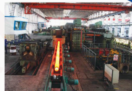
▲ 穿孔机 PIERCING MILL
